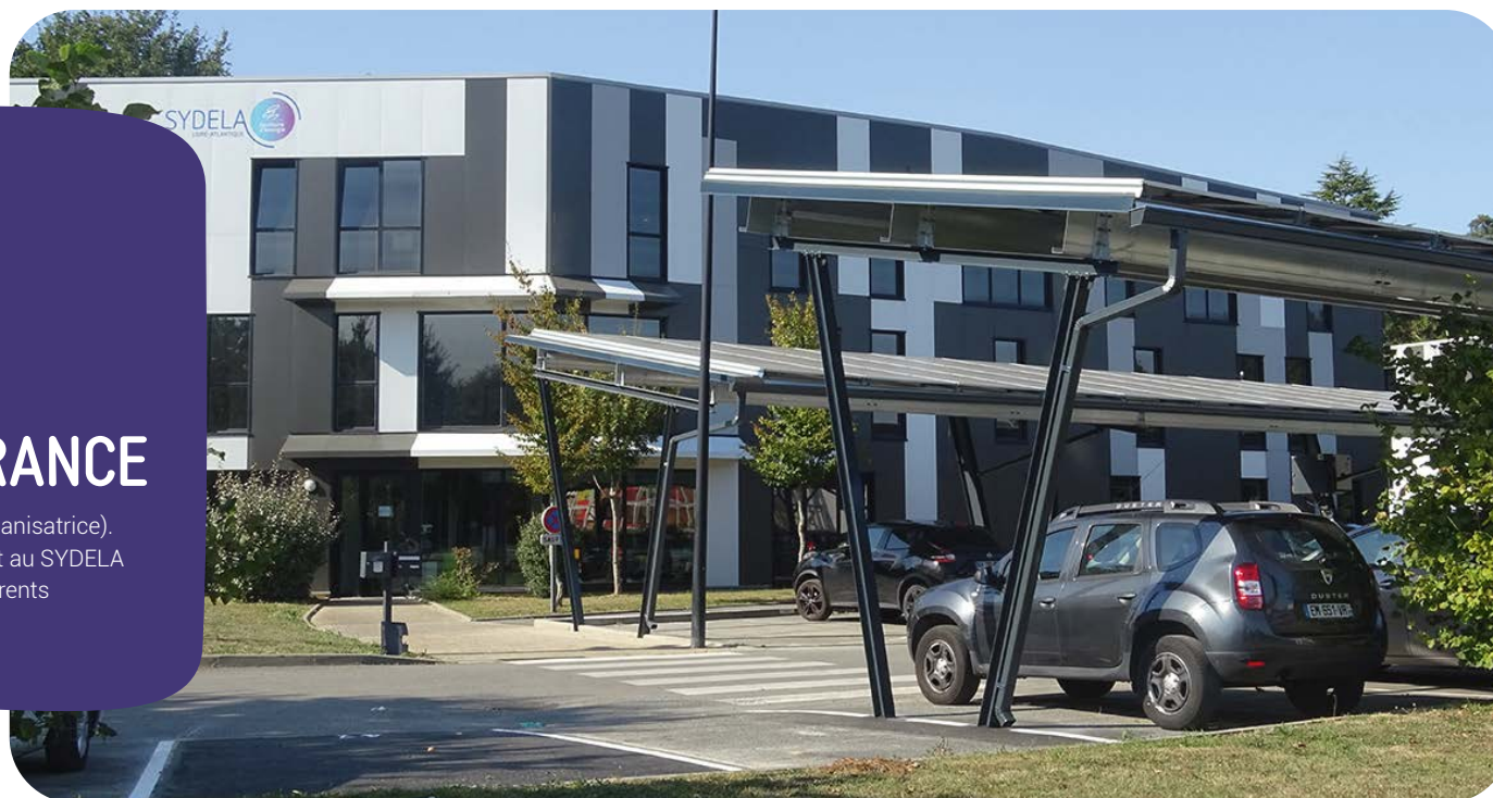
L'ombrière photovoltaïque de parking du SYDELA
